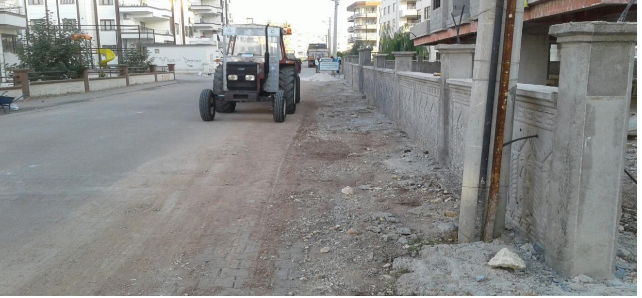
Resim 6.1 İmambakır mahallesi 758.sokak yol bakım onarım çalışmasından görünüm. (Eski hali)
