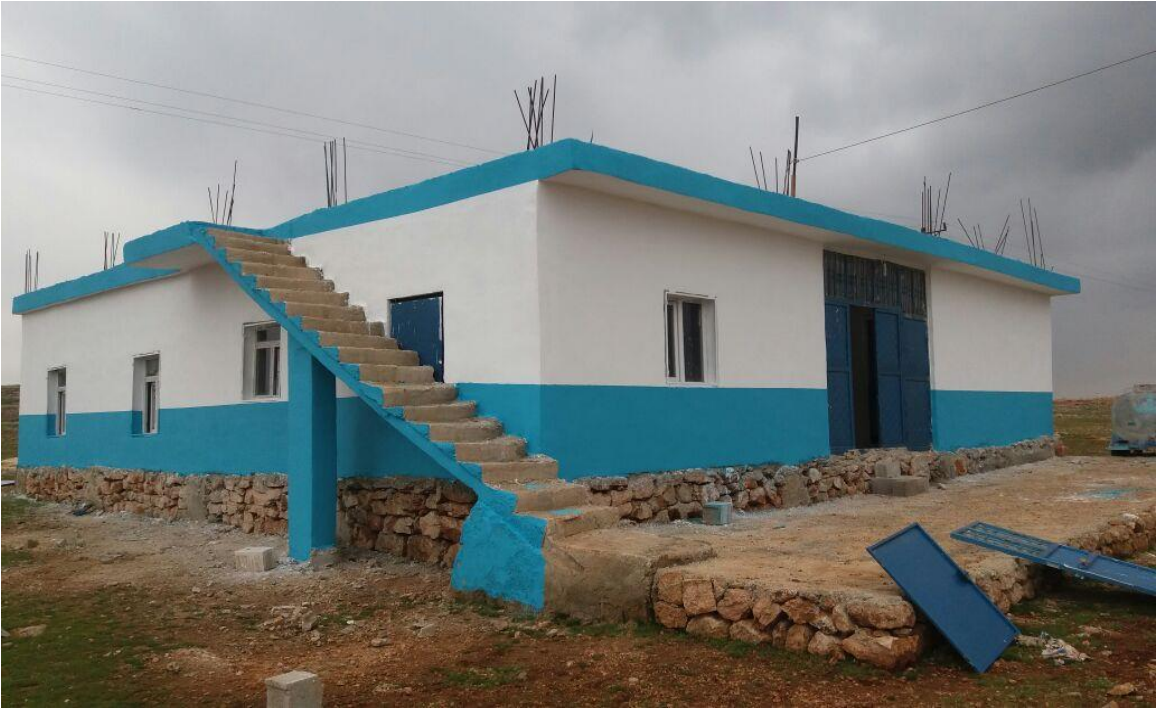
Resim 15.2 Uluhan(Dörtyol) Mahallesi'nde taziye evi bakım onarım çalışmalarımız.(Yeni hali)
