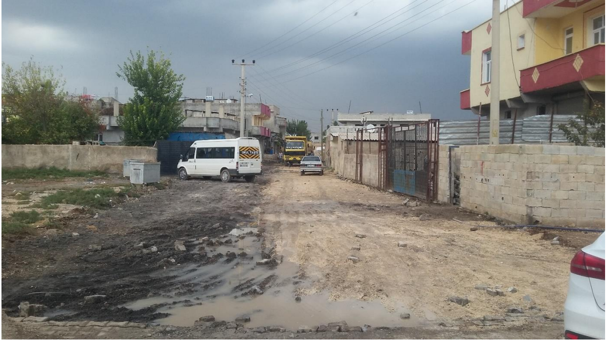
Resim 4.1 : Konuklu mahallesi Beton Parke Kaplama Çalışması(Eski Hali)
