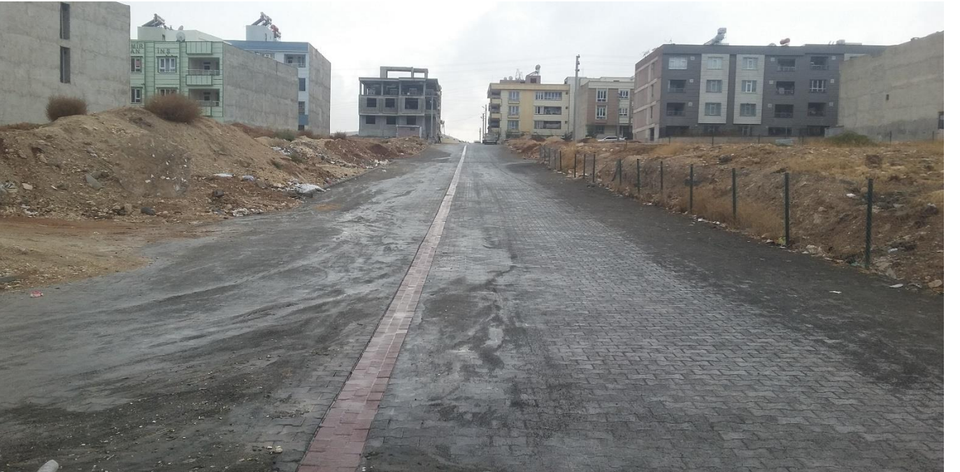
Resim 2.2 : Devteşti mahallesi 9603.sokak Beton Parke Kaplama Çalışmasından görünüm. (Yeni hali)
