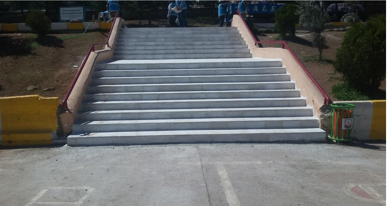
Resim 20.2 İpekyol mahallesi 2351.sokak Halide Nusret Zorlu Tuna İlk Okulu Basamakların bakım onarım çalışmalarımız.(Yeni hali)
