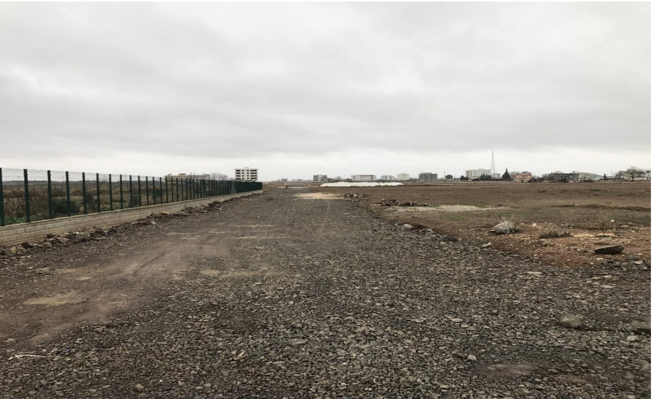
Resim 10.2 Konuklu Mahallesi'nde yeni yol açma çalışması(Yeni Hali)
