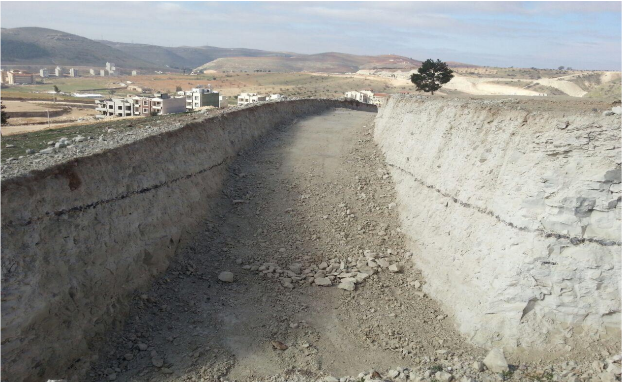
Resim 8.2 Devteşti Mahallesi'nde yeni yol açma çalışması(Yeni Hali)
