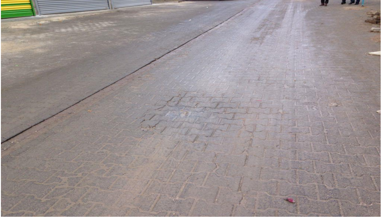
Resim 5.2 : Ahmet Yesevi mahallesi 2239.sokak yol bakım onarım çalışmasından görünüm. (Yeni
