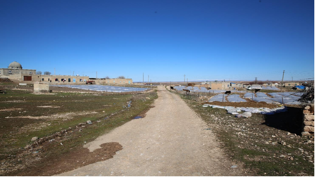
Resim 12.1 Eđerkırın Mahallesiinde stabilize yol alıřması (Eski Hali)
