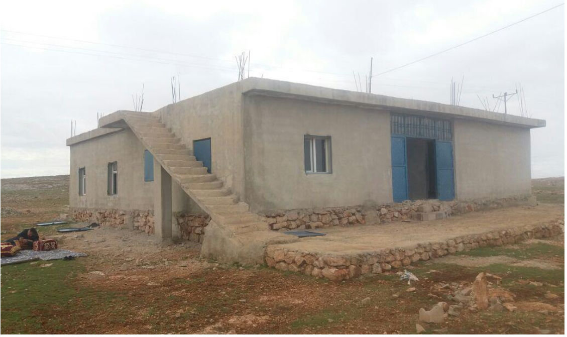
Resim 15.1 Uluhan(Dörtyol) Mahallesi'nde taziye evi bakım onarım çalışmalarımız.(Eski hali)
