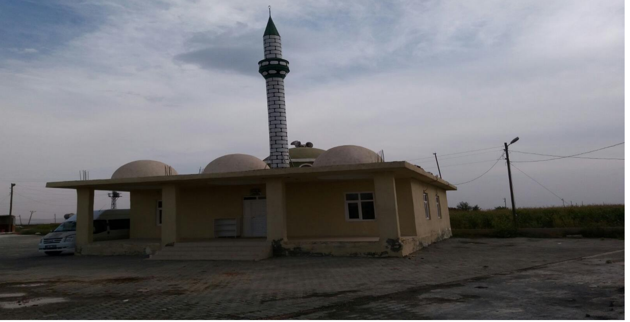
Resim 17.1 Mutluca Mahallesi cami bakım onarım çalışmalarımız.(Eski hali)
