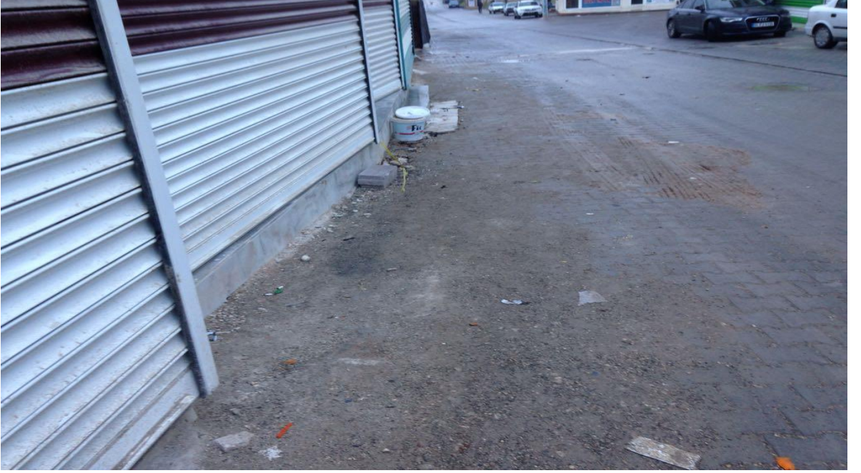
Resim 5.1 : Ahmet Yesevi mahallesi 2239.sokak yol bakım onarım çalışmasından görünüm.
