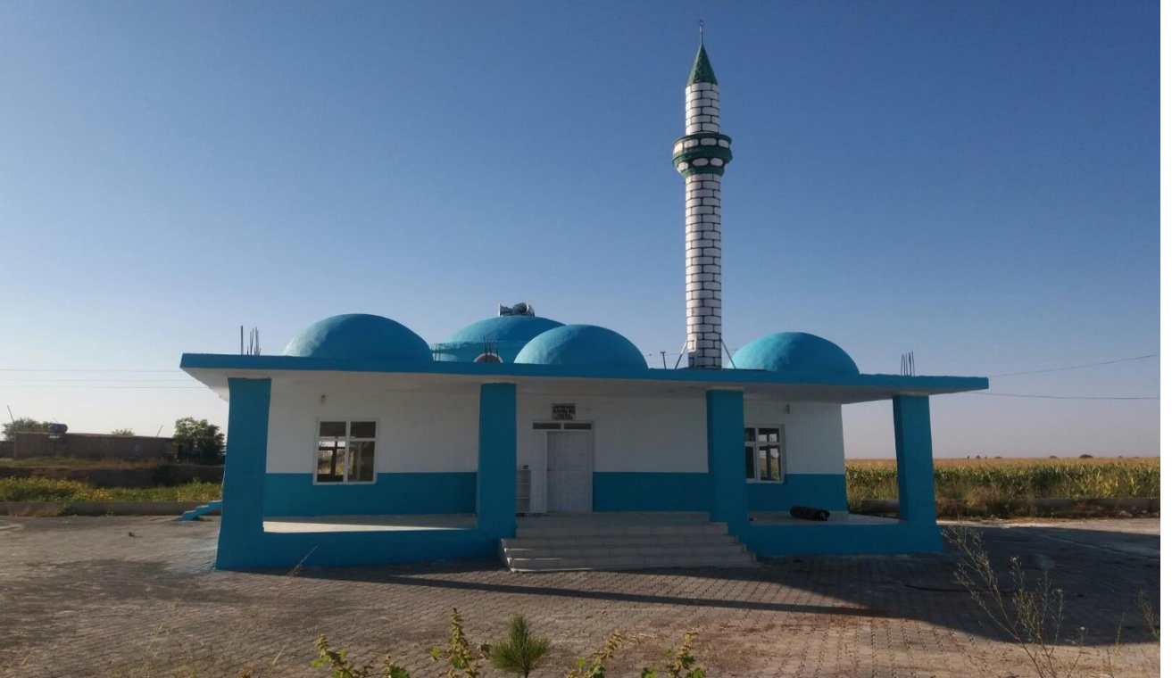
Resim 17.2 Mutluca Mahallesi cami bakım onarım çalışmalarımız.(Yeni hali)
