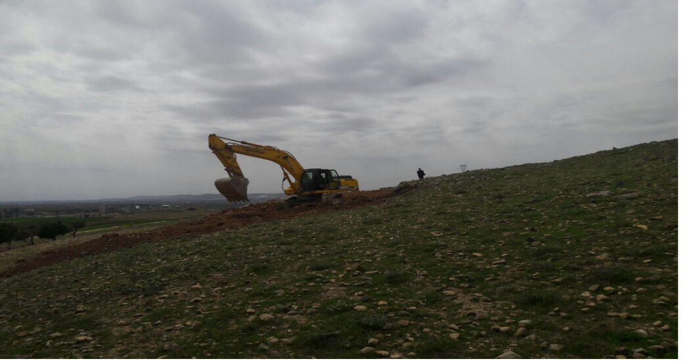
Resim 9.2 Dağeteği(Doktorlar sitesi) Mahallesinde yeni yol açma çalışması(Eski Hali)
