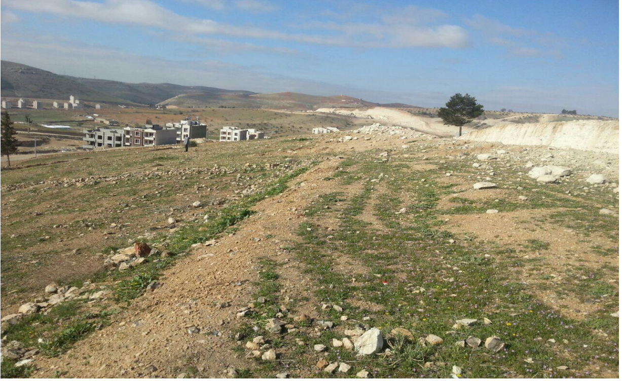
Resim 8.1 Devteşti Mahallesi'nde yeni yol açma çalışması(Eski Hali)
