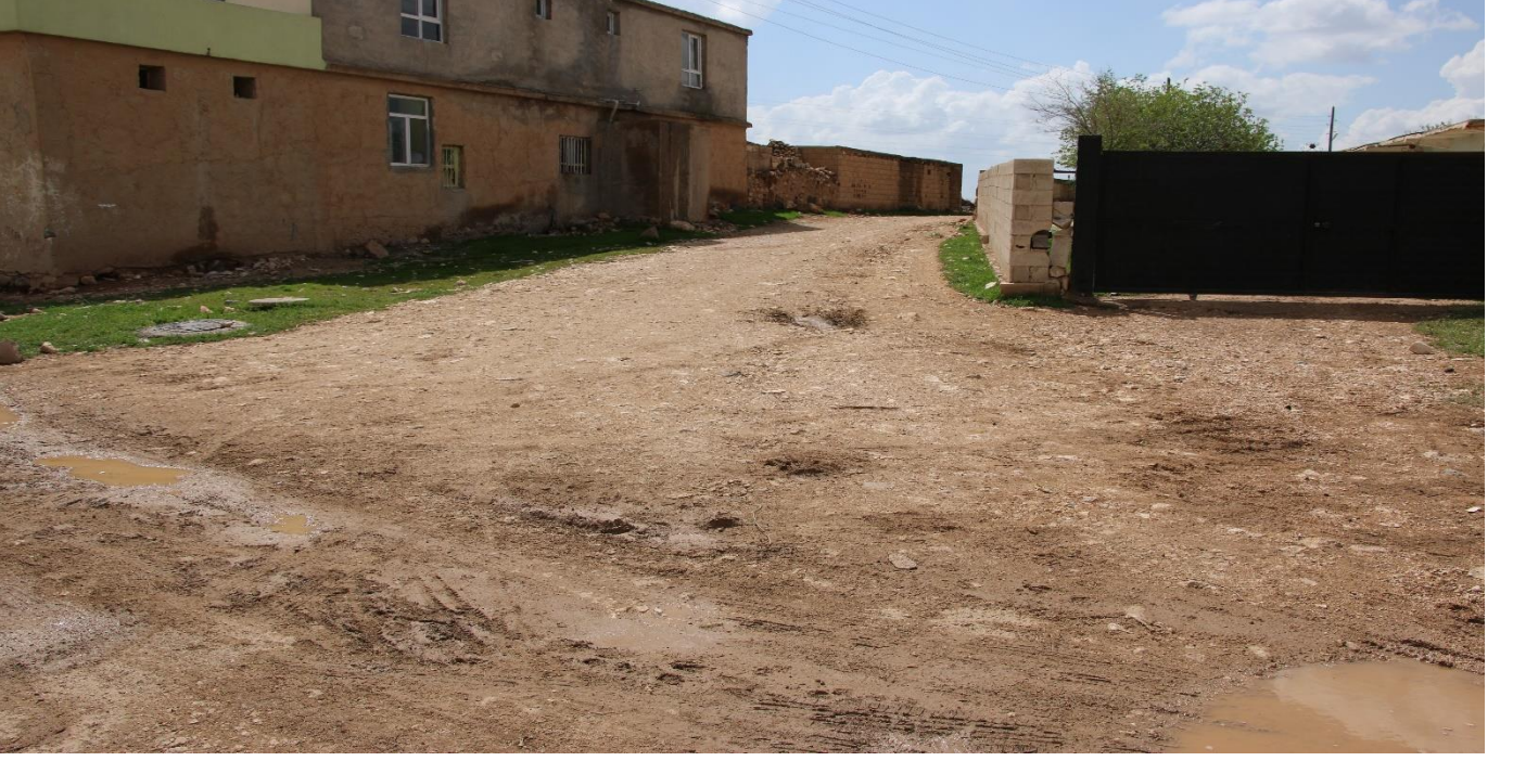
Resim 13.1 Göktepe Mahallesi'nde stabilize yol çalışması (Eski Hali)
