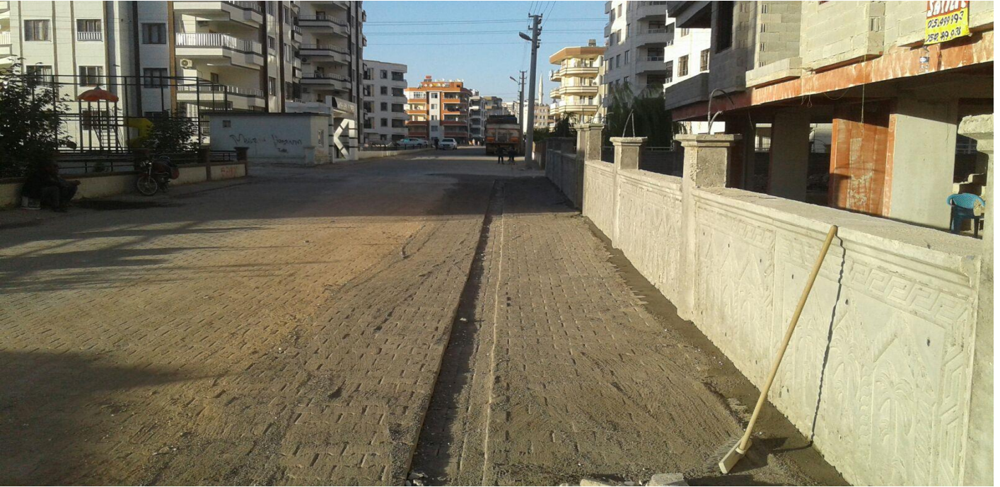
Resim 6.2 İmambakır mahallesi 758.sokak yol bakım onarım çalışmasından görünüm. (Yeni Hali)
