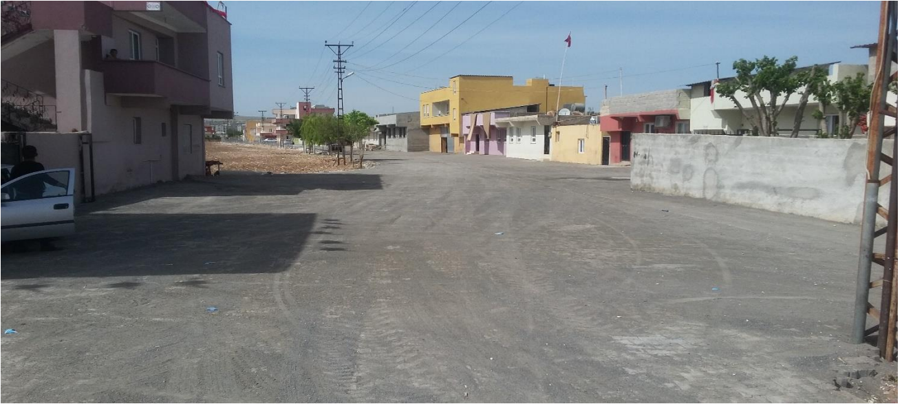
Resim 1.2 : Sırrın(Demirkan)mahallesi Beton Parke Kaplama Çalışmasından görünüm. (Yeni hali)
