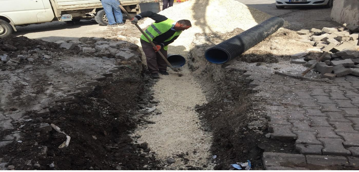
Resim 21.1 Devteşti mahallesi 2145.sokak büz boru döşeme çalışması
