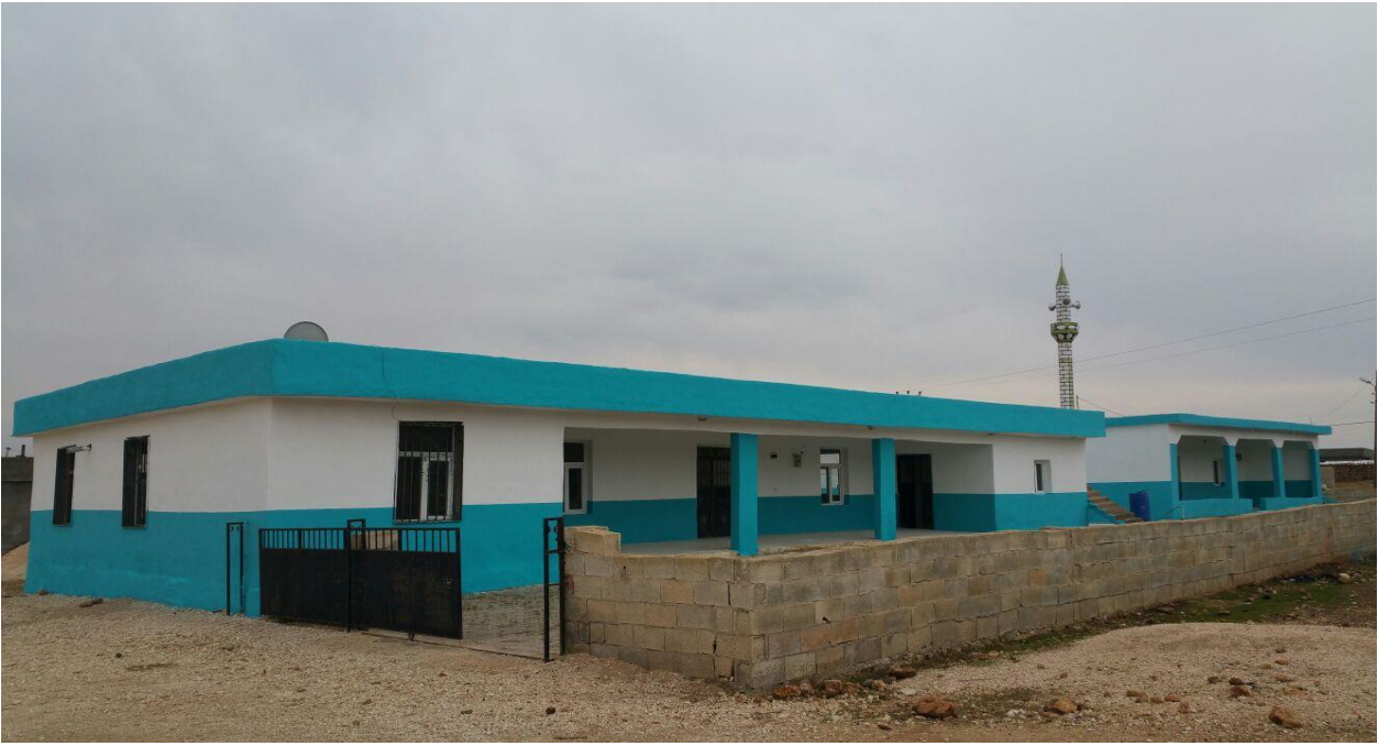
Resim 16.2 Ernebi Mahallesi'nde taziyevi ve cami bakım onarım çalışmaları.(Eski hali)
