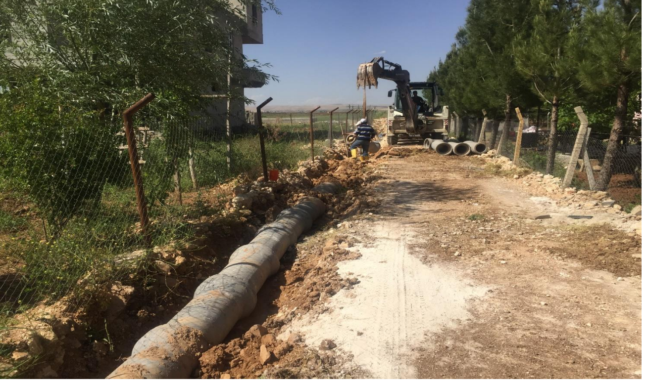
Resim 23.1 Kısa mahallesi büz boru döşeme çalışması
