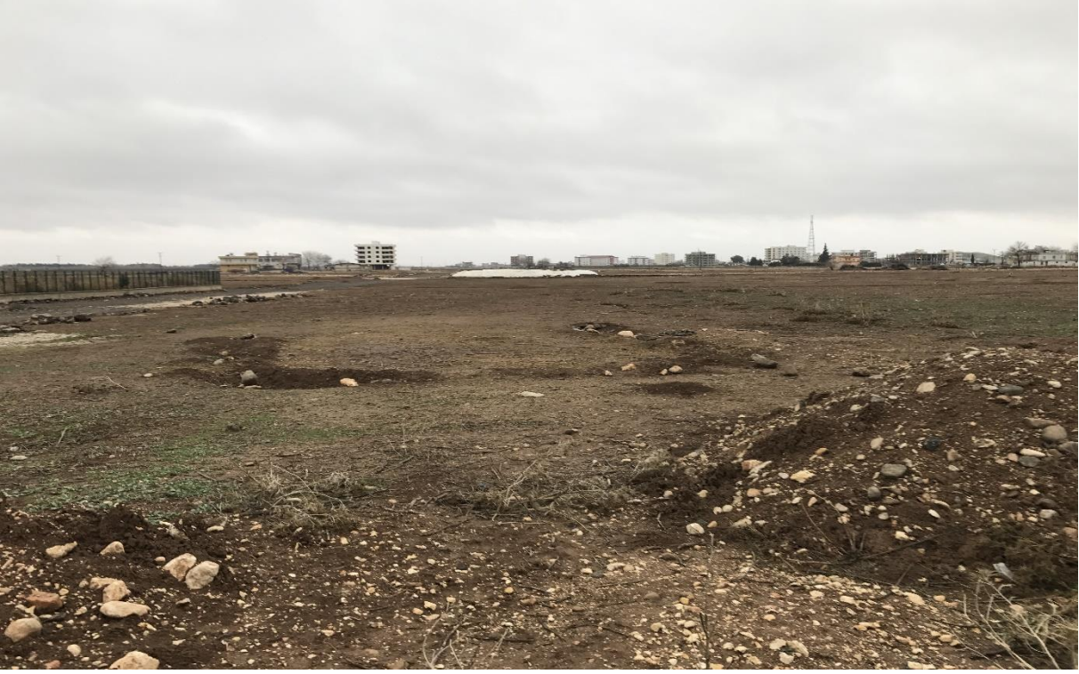
Resim 10.1 Konuklu Mahallesi'nde yeni yol açma çalışması(Eski Hali)
