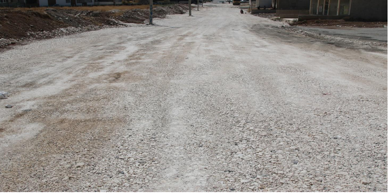
Resim 11.1 Ahmet Yesevi Mahallesinde stabilize çalışması(Eski Hali)
