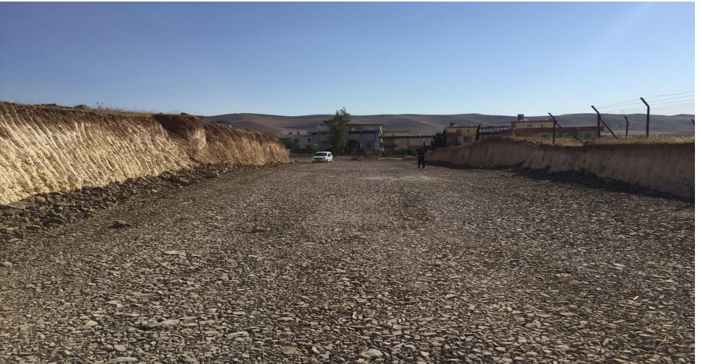
Resim 9.2 Dağeteği (Doktorlar sitesi) Mahallesinde yeni yol açma çalışması(Yeni Hali)
