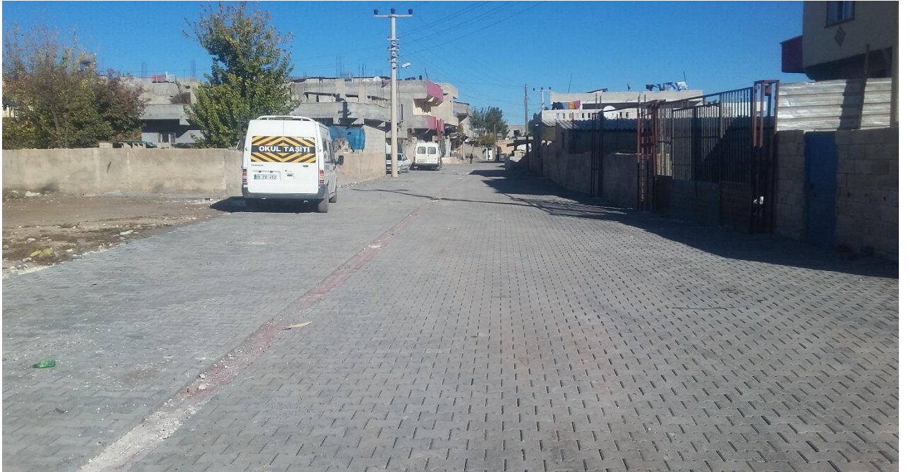
Resim 4.2 : Konuklu mahallesi Beton Parke Kaplama Çalışması(Yeni Hali)
