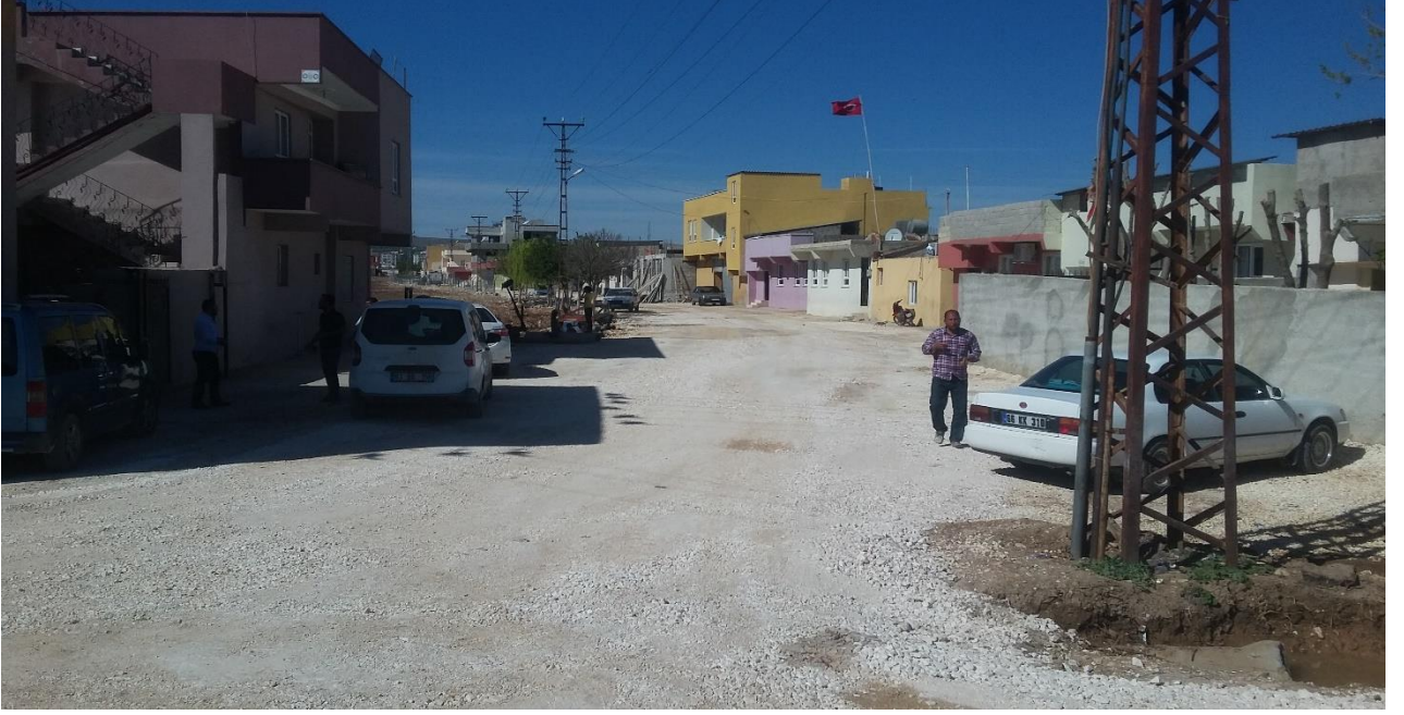
Resim 1.1 : Sırrın(Demirkan) mahallesi Beton Parke Kaplama Çalışmasından görünüm.(Eski Hali)
