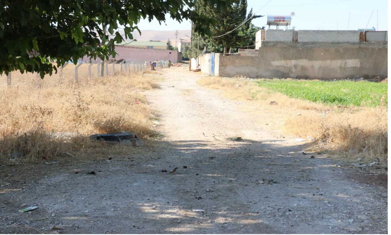
Resim 3.1 : Ulubağ mahallesi 16313.sokak Beton Parke Kaplama Çalışması(Eski Hali)
