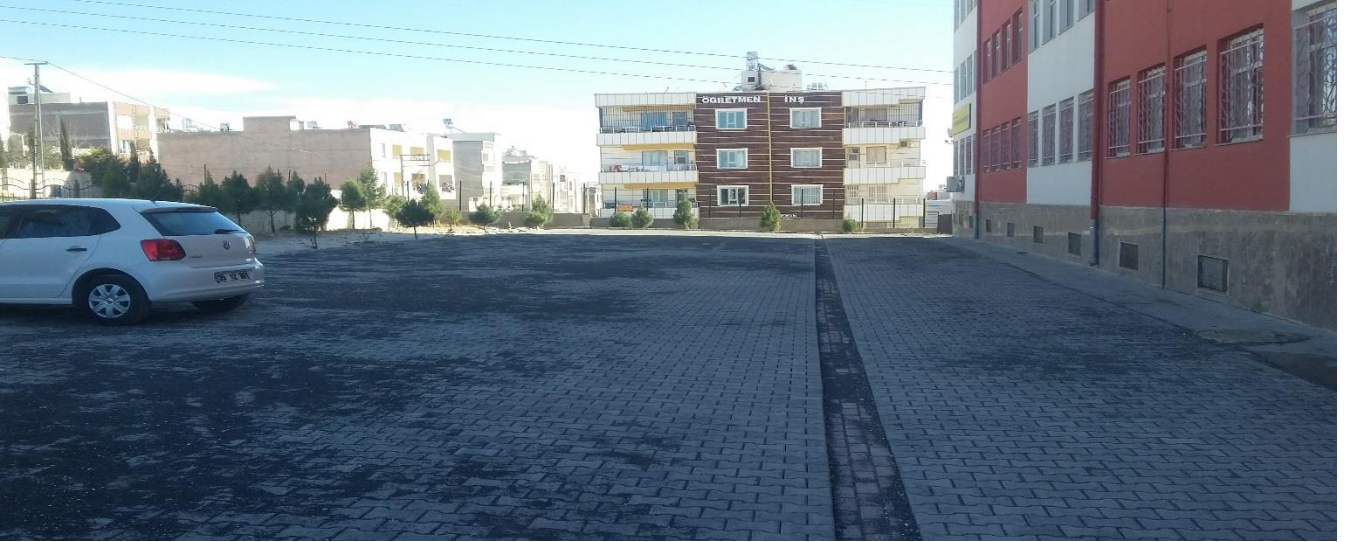
Resim 20.2 Devteşti Mahallesi 9642.sokak Süleymaniye Anadolu İmam Hatip Lisesi okul bahçesi bakım onarım çalışmalarımız.(Yeni hali)
