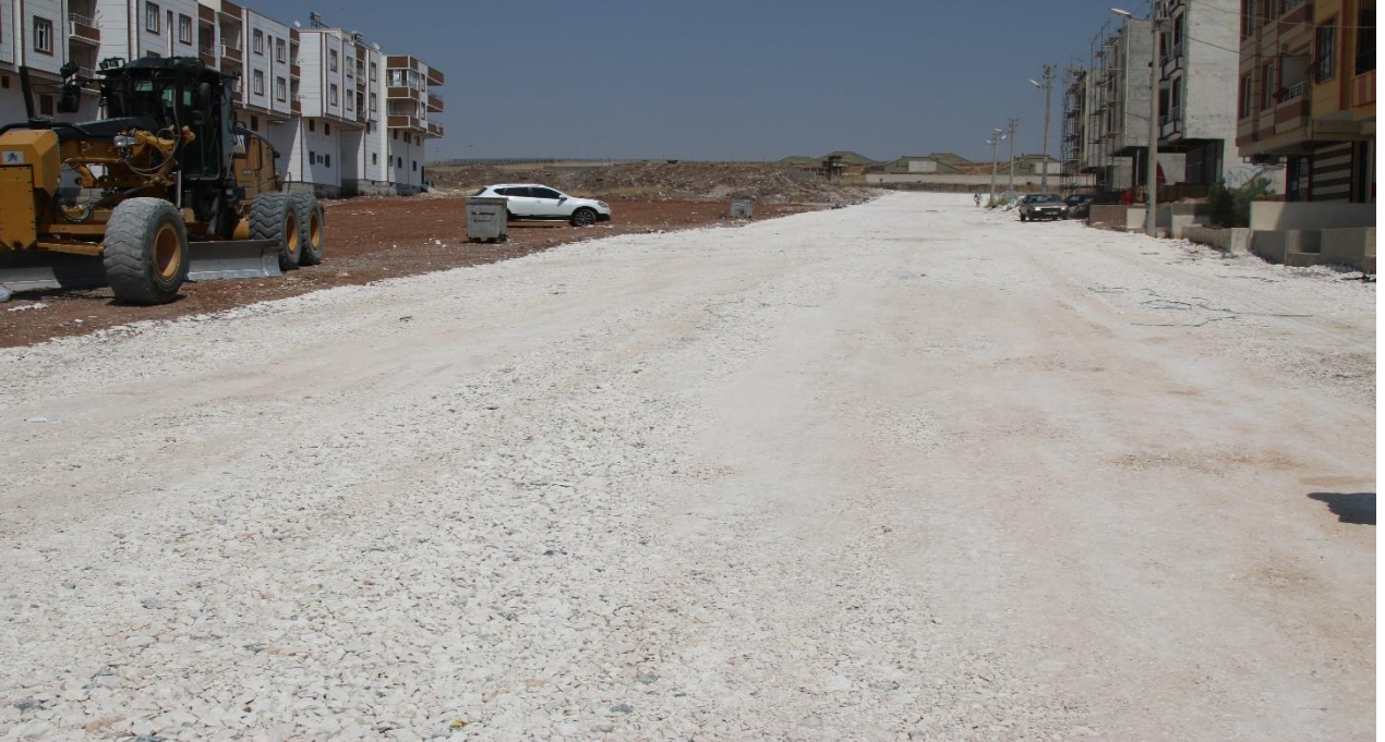
Resim 11.2 Ahmet Yesevi Mahallesinde stabilize çalışması(Yeni Hali)
