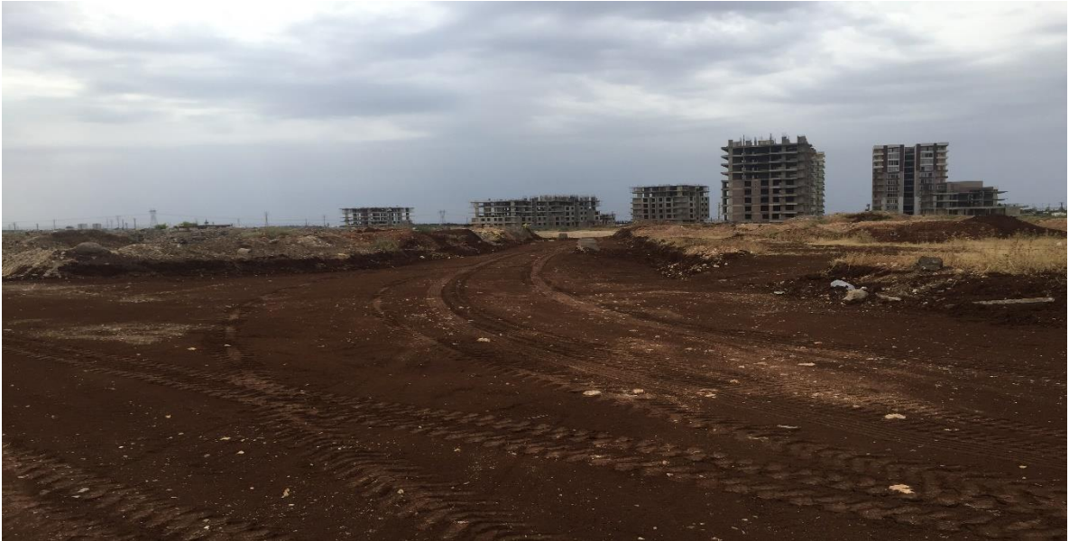
Resim 7.2 Dağeteği(Yeşilurfa) Mahallesi'nde yeni yol açma çalışmasından sonraki görünüm(Yeni Hali)
