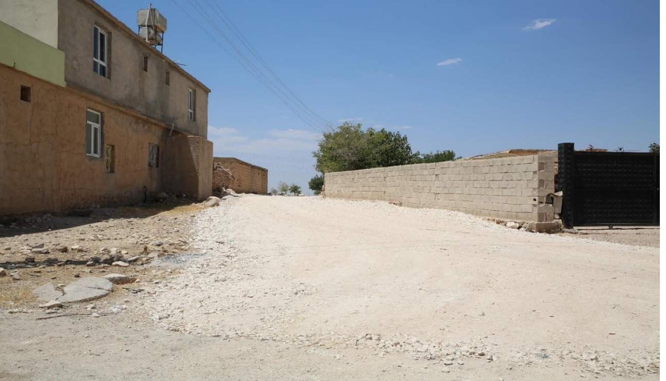
Resim 13.2 Göktepe Mahallesi'nde stabilize yol çalışması (Yeni Hali)
