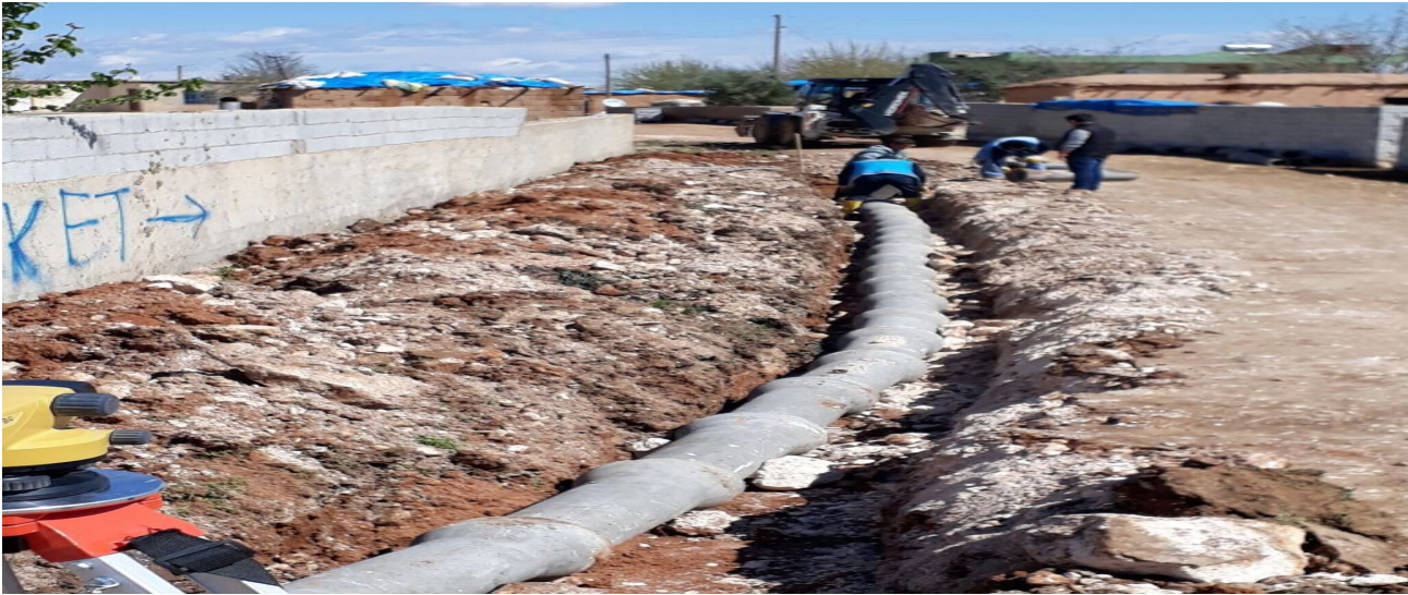
Resim 21.1 Devteşti mahallesi 2145.sokak büz boru döşeme çalışması
