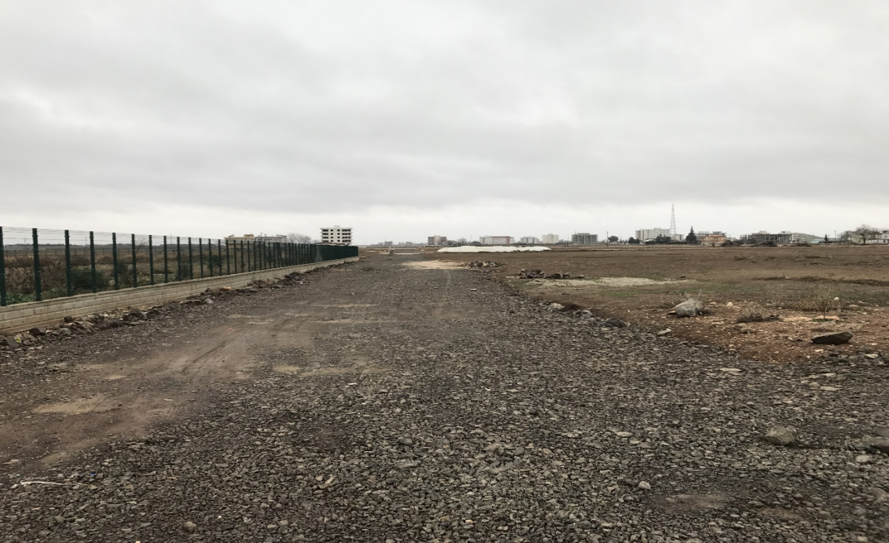
Resim 10.2 Konuklu Mahallesi'nde yeni yol açma çalışması(Yeni Hali)
