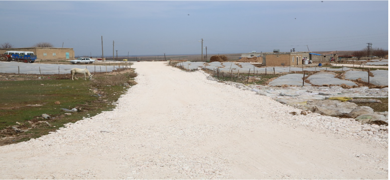
Resim 12.2 Eđerkırın Mahallesi'nde stabilize yol çalışması (Yeni Hali)
