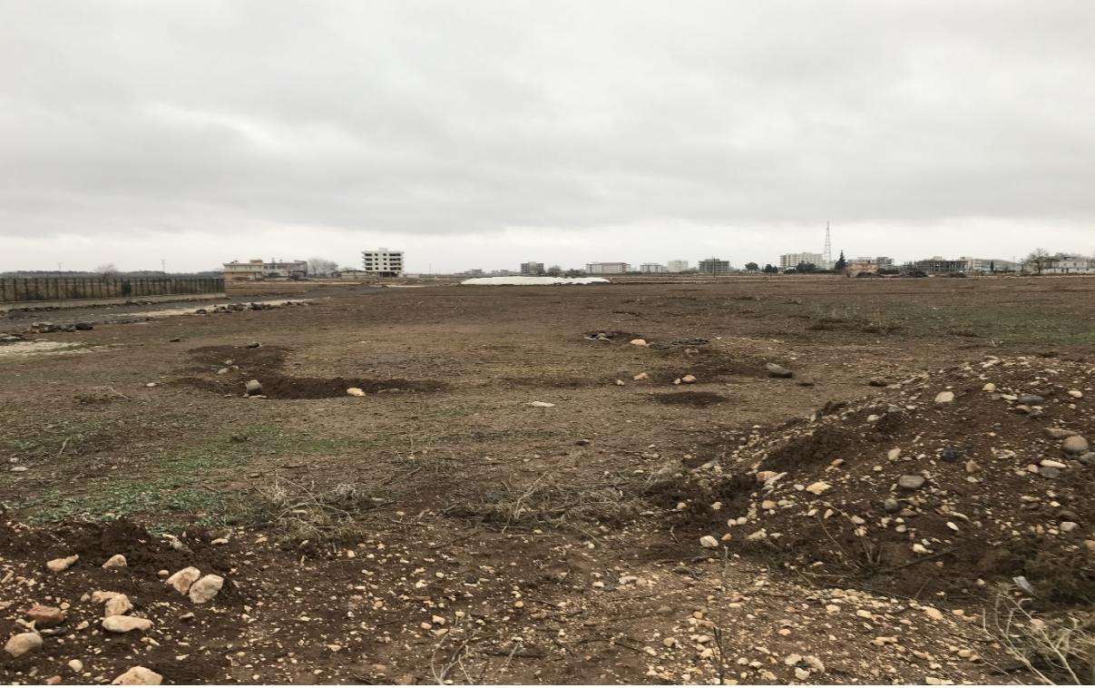
Resim 10.1 Konuklu Mahallesi'nde yeni yol açma çalışması(Eski Hali)
