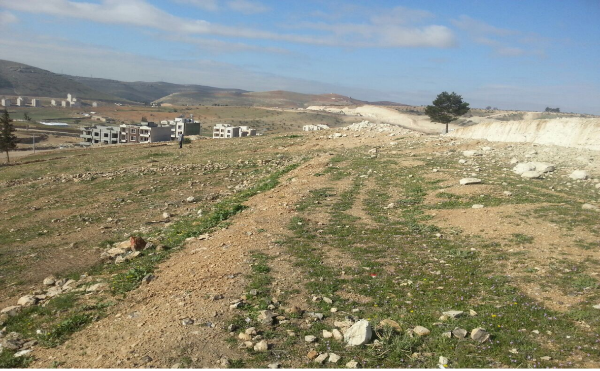
Resim 8.1 Devteşti Mahallesi'nde yeni yol açma çalışması(Eski Hali)
