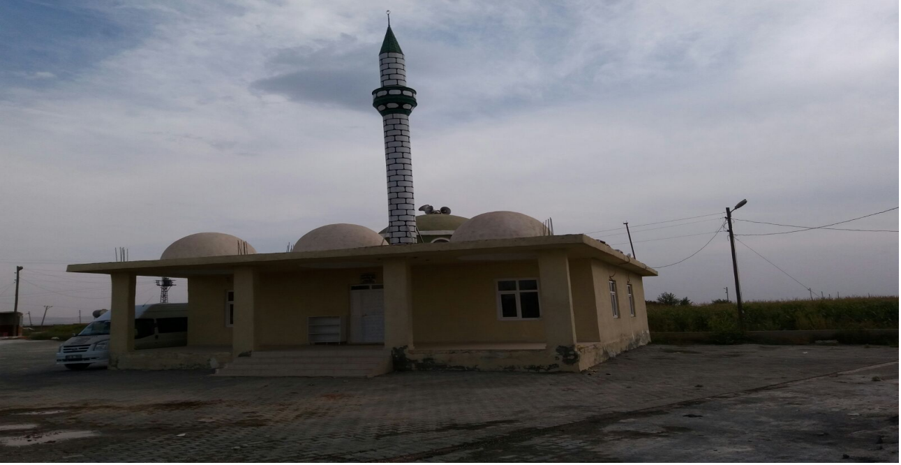
Resim 17.1 Mutluca Mahallesi cami bakım onarım çalışmaları.(Eski hali)
