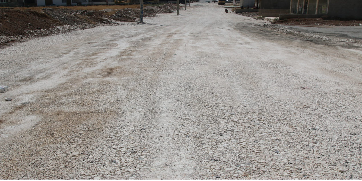
Resim 11.1 Ahmet Yesevi Mahallesinde stabilize çalışması(Eski Hali)
