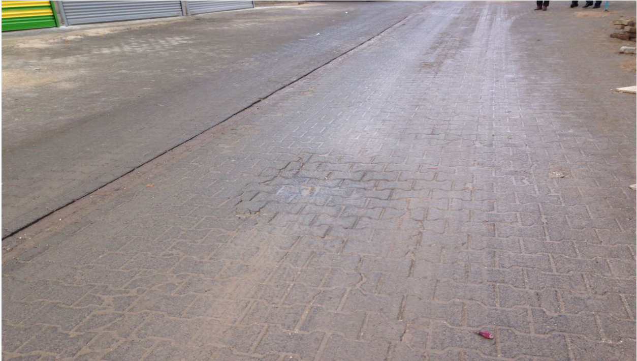
Resim 5.2 : Ahmet Yesevi mahallesi 2239.sokak yol bakım onarım çalışmasından görünüm. (Yeni
