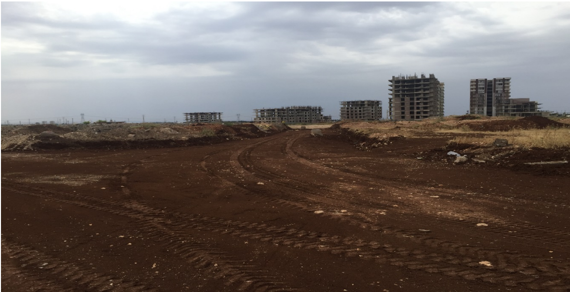
Resim 7.2 Dağeteği (Yeşilurfa) Mahallesi'nde yeni yol açma çalışmasından sonraki görünüm (Yeni Hali)
