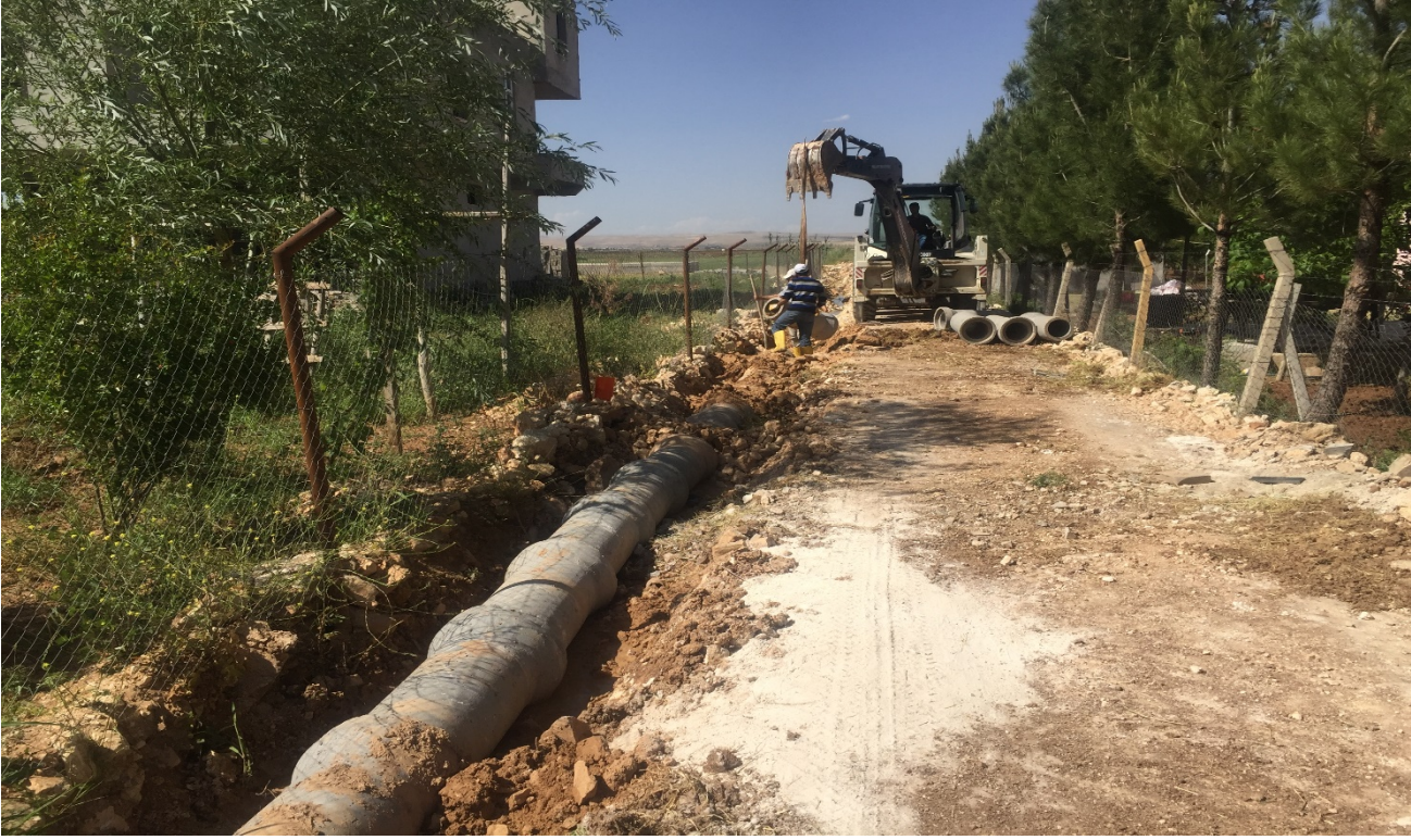
Resim 23.1 Kıyas mahallesi büz boru döşeme çalışması
