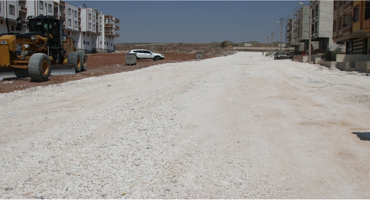
Resim 11.2 Ahmet Yesevi Mahallesinde stabilize çalışması(Yeni Hali)
