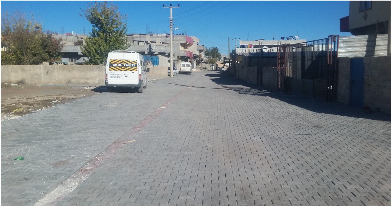
Resim 4.2 : Konuklu mahallesi Beton Parke Kaplama Çalışması(Yeni Hali)
