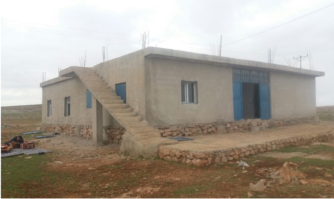
Resim 15.1 Uluhan(Dört Yol) Mahallesi'nde taziyevi bakım onarım çalışmaları.(Eski hali)
