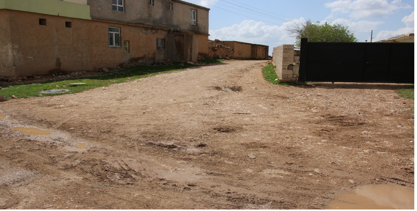
Resim 13.1 Göktepe Mahallesi'nde stabilize yol çalışması (Eski Hali)
