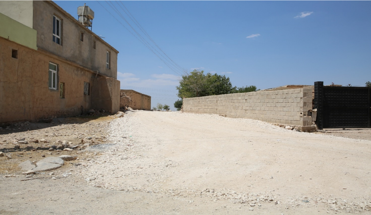
Resim 13.2 Göktepe Mahallesi'nde stabilize yol çalışması (Yeni Hali)
