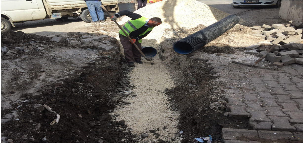
Resim 21.1 Devteşti mahallesi 2145.sokak büz boru döşeme çalışması
