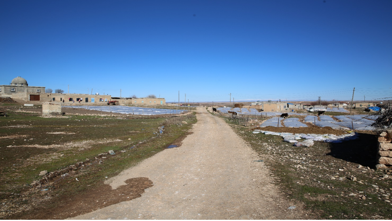
Resim 12.1 Eđerkırın Mahallesi'nde stabilize yol çalışması (Eski Hali)
