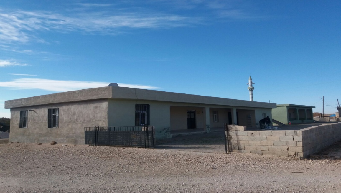
Resim 16.1 Ernebi Mahallesi'nde taziyevi ve cami bakım onarım çalışmaları.(Eski hali)
