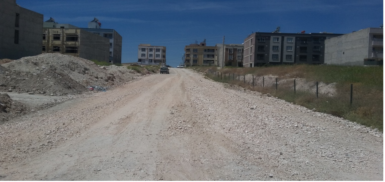
Resim 2.1 : Devteşti mahallesi 9603.sokak Beton Parke Kaplama Çalışmasından görünüm. (Eski hali)
