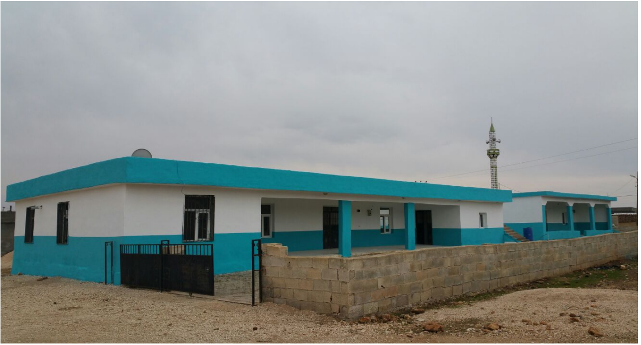
Resim 16.2 Ernebi Mahallesi'nde taziyevi ve cami bakım onarım çalışmaları.(Eski hali)
