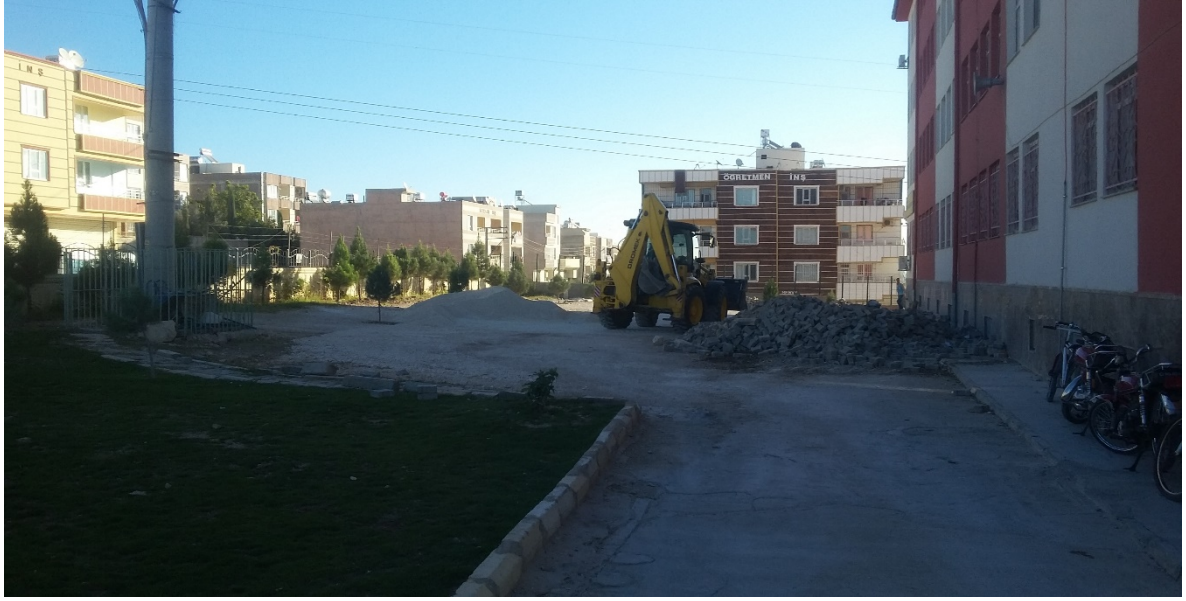
Resim 20.1 Devteşti Mahallesi 9642.sokak Süleymaniye Anadolu İmam Hatip Lisesi okul bahçesi bakım onarım çalışmalarımız.(Eski hali)
