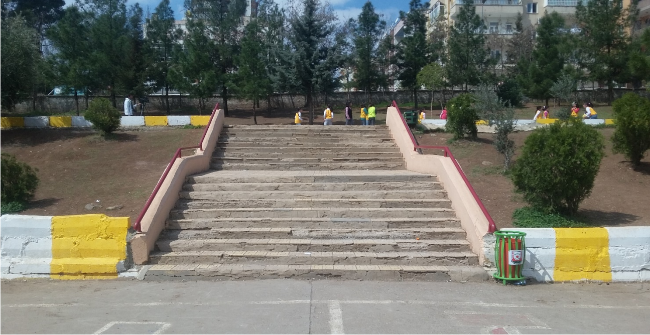
Resim 21.1 İpekyol Mahallesi 2351.sokak Halide Nusret Zorlu Tuna İlk Okulu Basamakların bakım onarım çalışmalarımız.(Eski hali)
