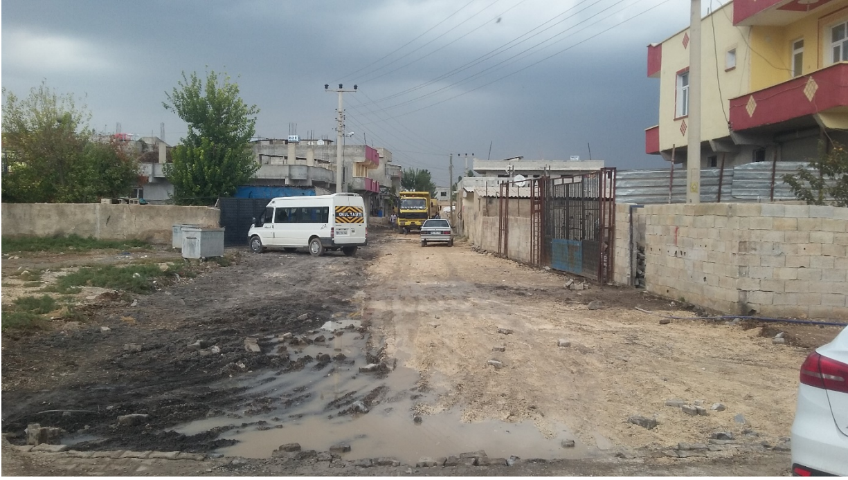
Resim 4.1 : Konuklu mahallesi Beton Parke Kaplama Çalışması(Eski Hali)
