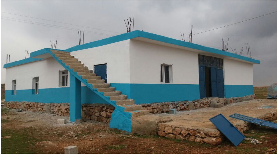
Resim 15.2 Uluhan(Dört Yol) Mahallesi'nde taziyevi bakım onarım çalışmaları.(Yeni hali)
