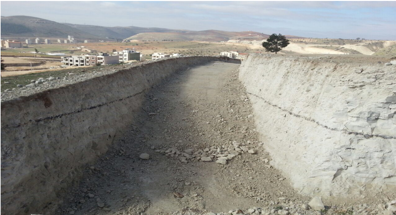
Resim 8.2 Devteşti Mahallesi'nde yeni yol açma çalışması(Yeni Hali)
